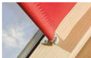
τα στηρίγματα στο πλαίσιο – τρεις διαφορετικές θέσεις συγκράτησης
